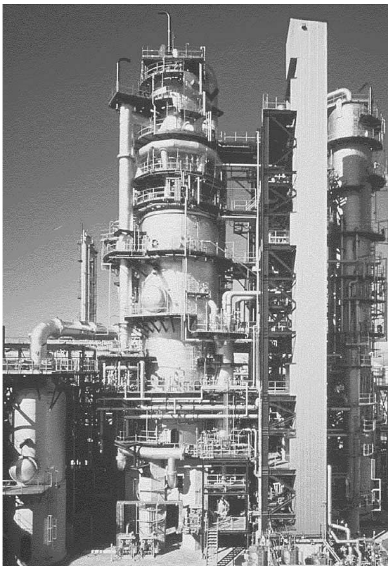
Рис. 3.1.1. Установка FCC Orthoflow компании KBR
